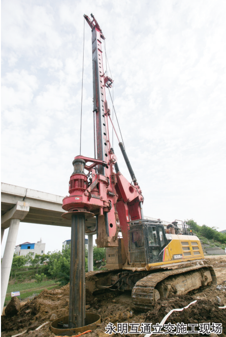
永明互通立交施工现场
