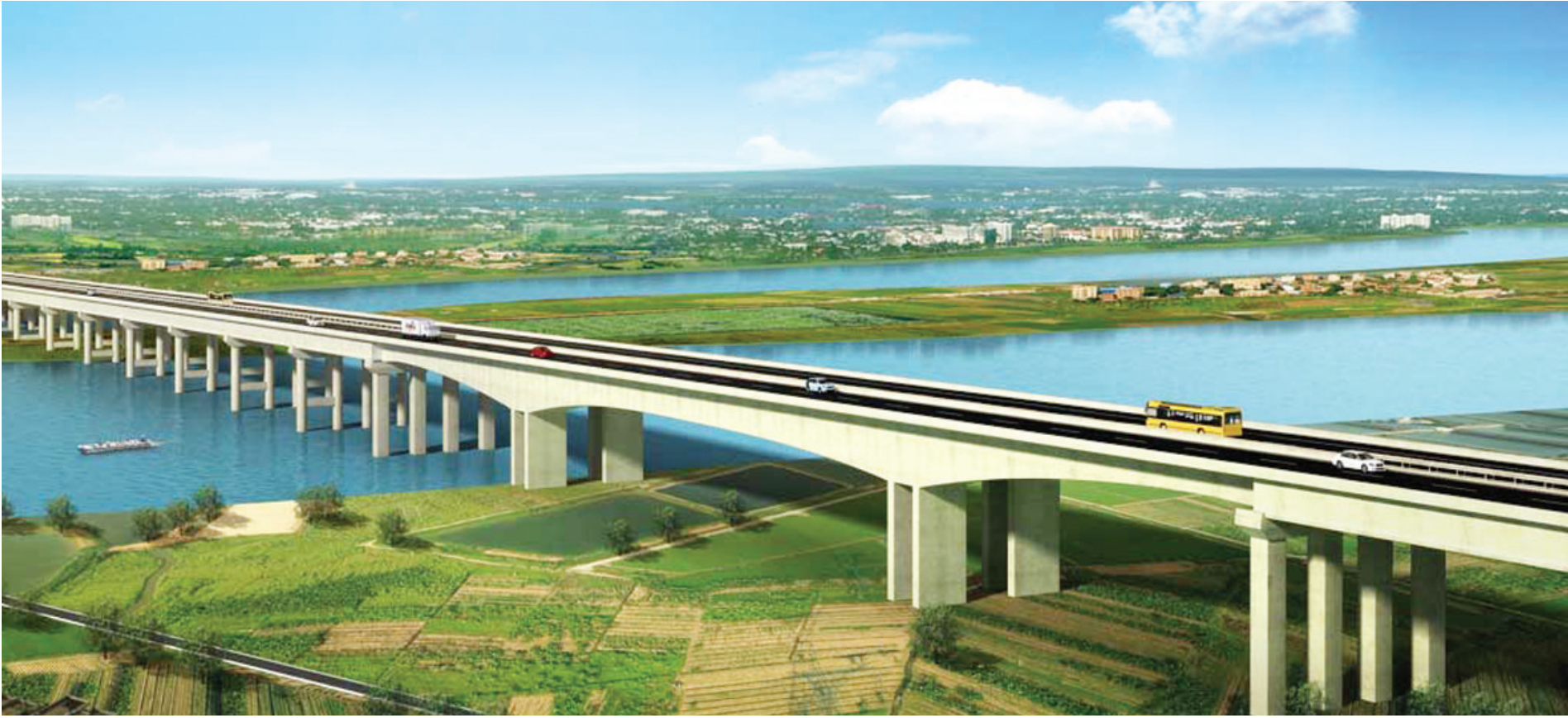
绵阳绕城高速公路南环线项目
