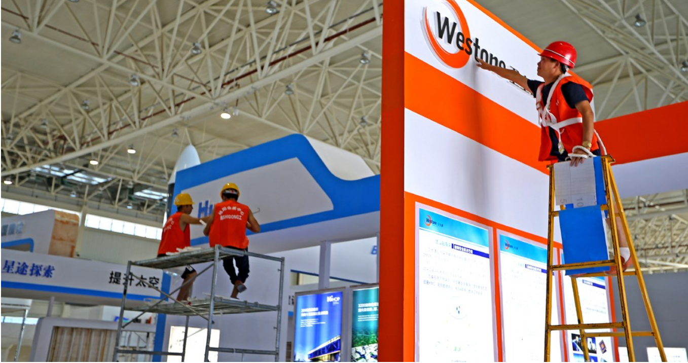
昨(3)日,科博会展馆内,工人正加紧场馆搭建和最后的收尾工作。(本报记者 蒲滔 摄)
