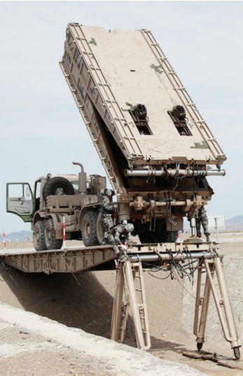
中方参赛官兵展开桥跨,架设桥梁
