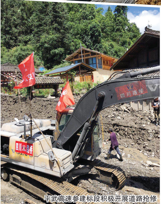
平武高速参建标段积极开展道路抢修
