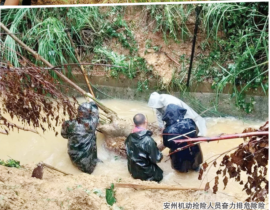
安州机动抢险人员奋力排危除险
