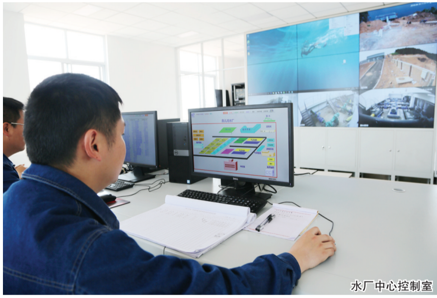
水厂中心控制室
