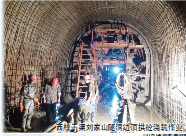
西梓干渠刘家山隧洞边顶拱浇筑作业
