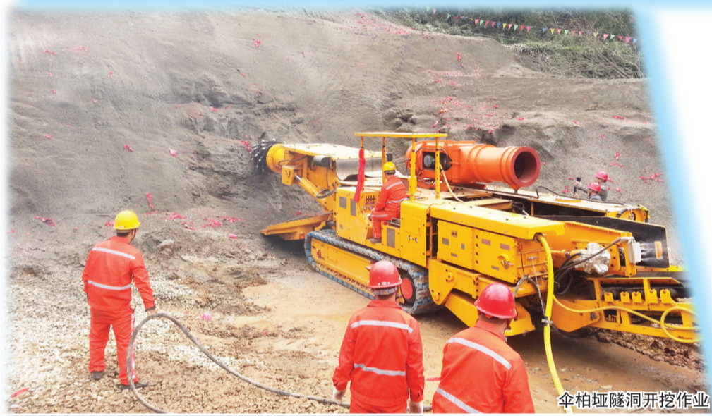
伞柏垭隧洞开挖作业
