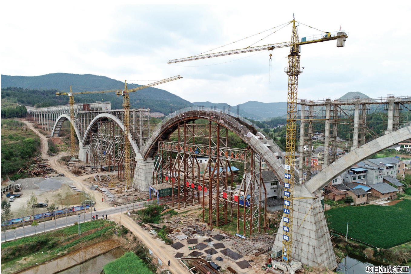
项目加紧施工
