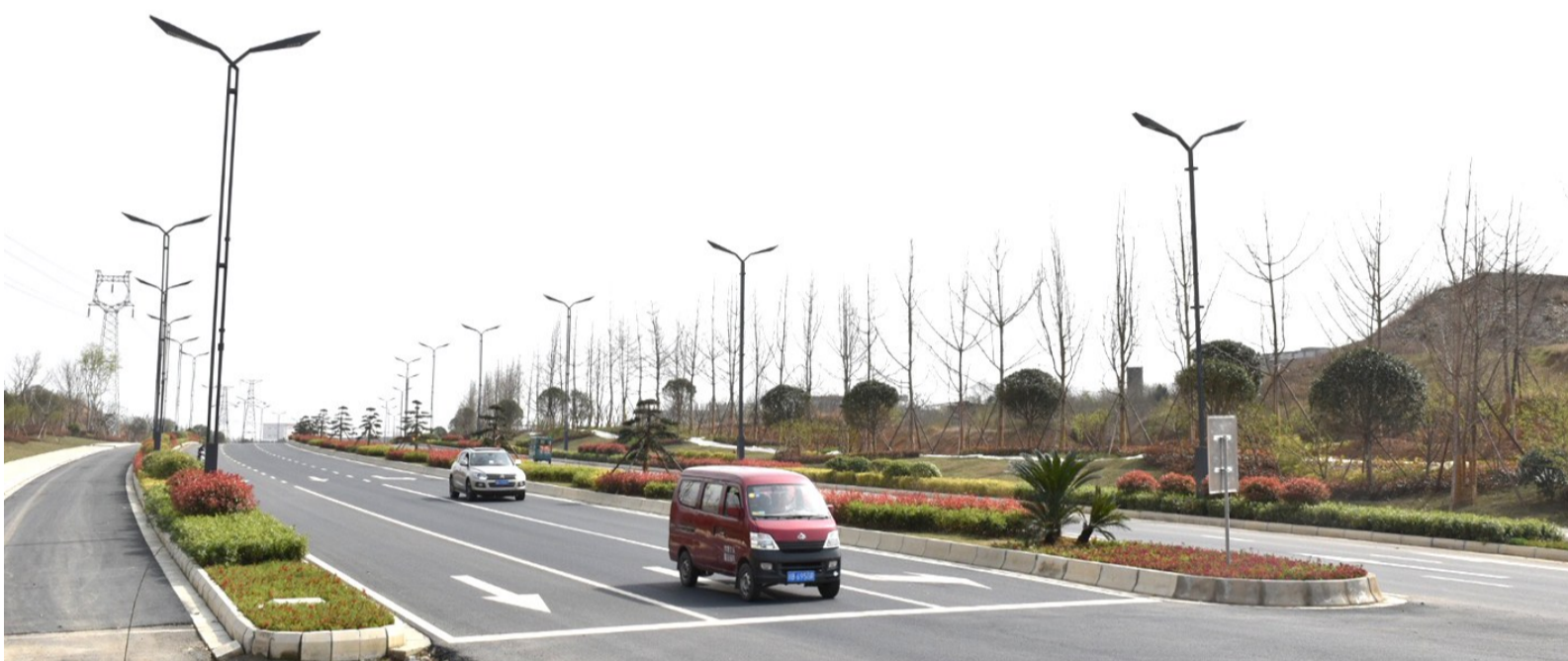
省道S205改线工程一期路段建成通车
