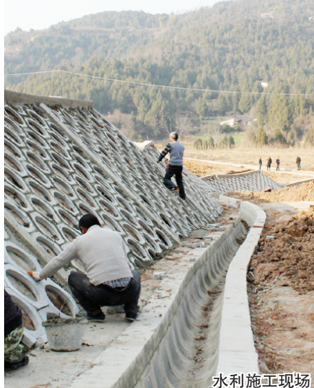
水利施工现场
