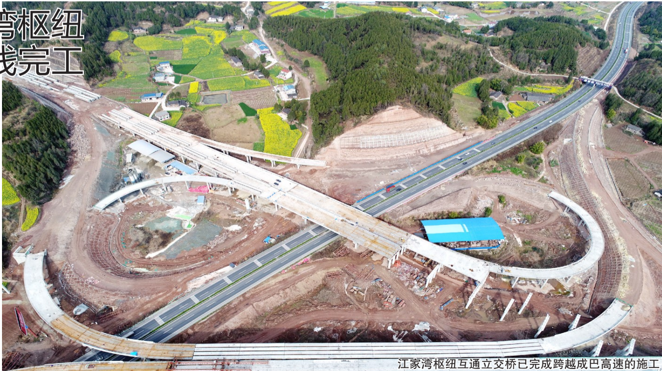
江家湾枢纽互通立交桥已完成跨越成巴高速的施工。
