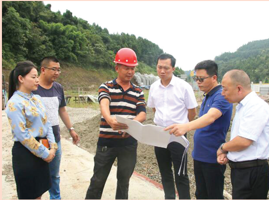
县政府领导在特色小镇施工现场调研
