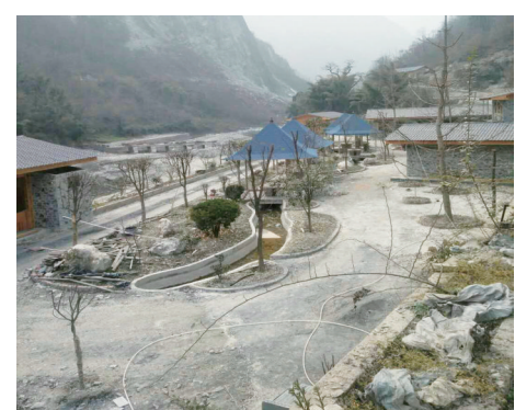
建设中的清溪谷漂流
