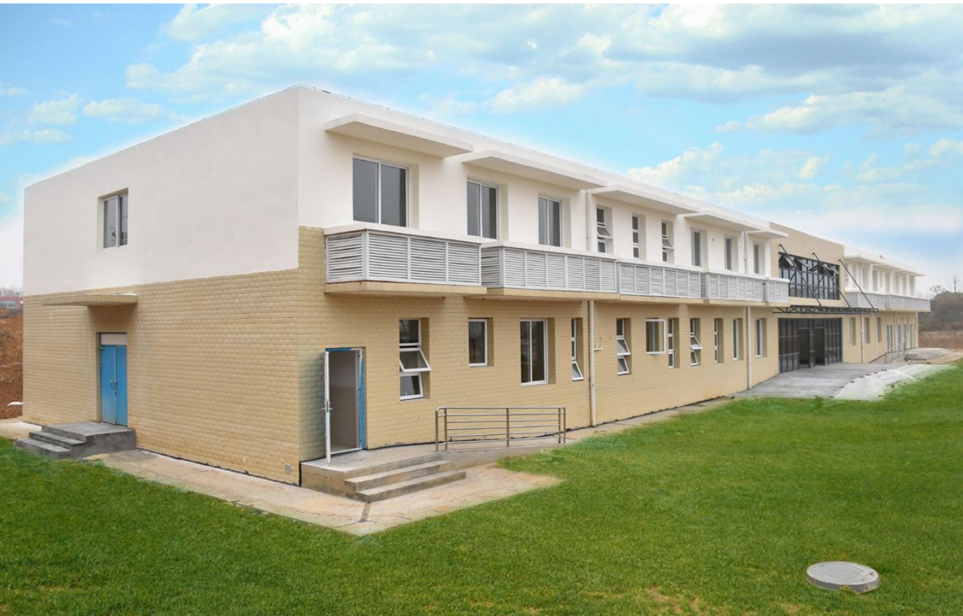
已竣工的石塘镇卫生院
