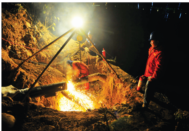
燃气管道施工
