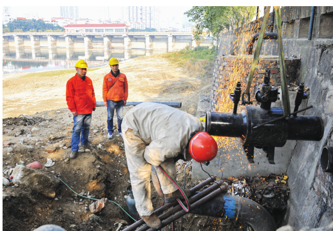
燃气管道施工
