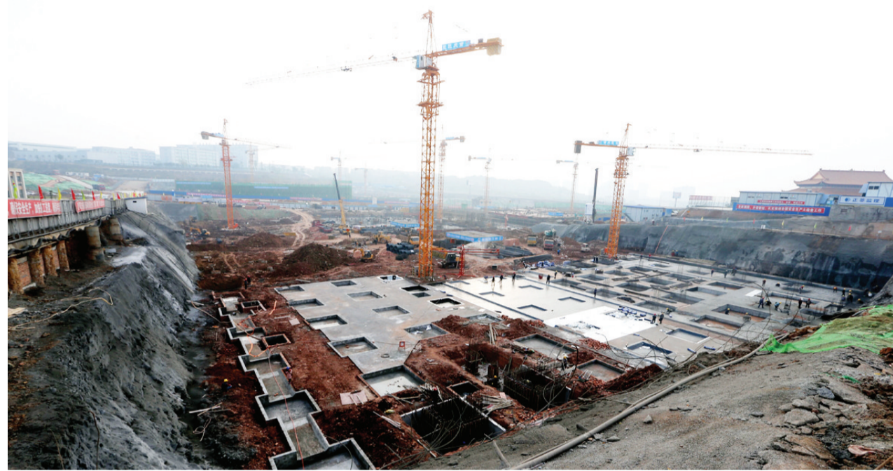
科创区高端产业园一期项目建设快速推进 (本报记者蒲滔摄)
