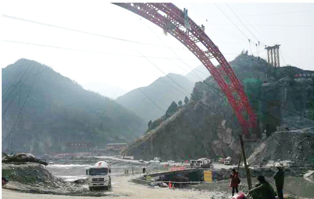
主拱混凝土顶升于24日晚顺利完工
