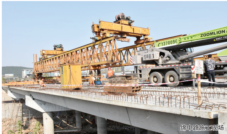
绵中路施工现场
