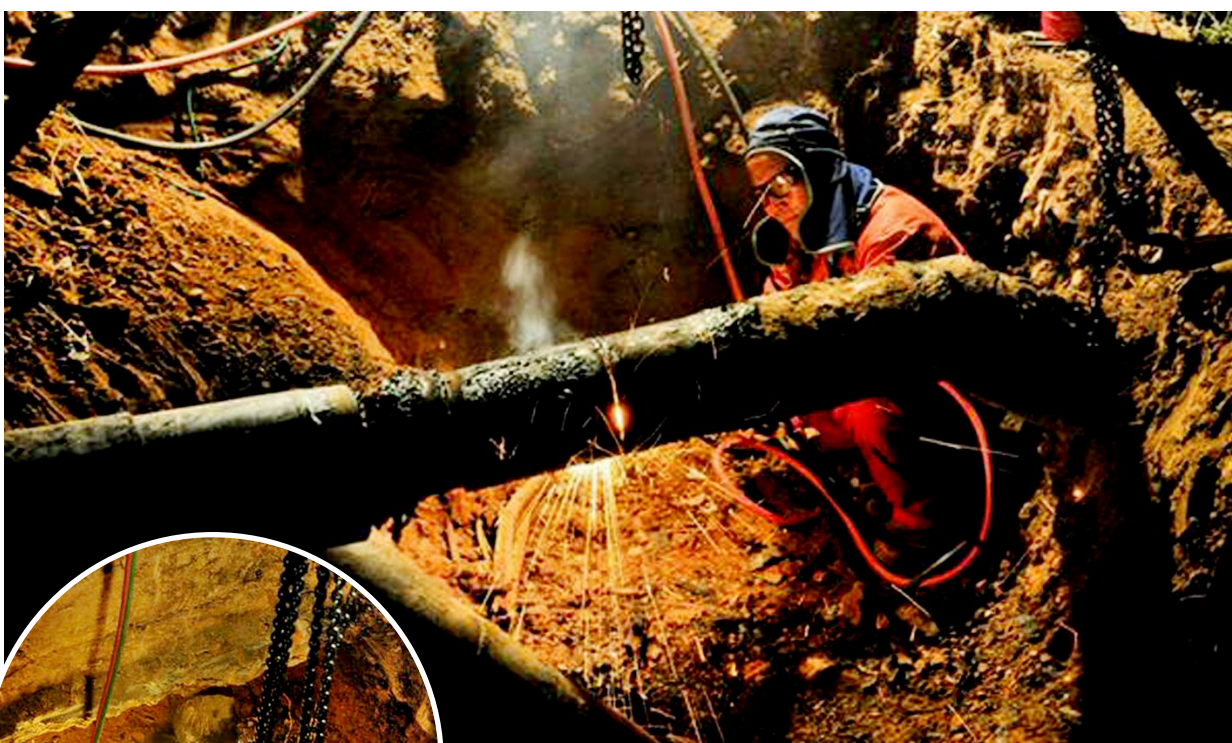
20 日 22 时,经过连夜紧张施工,位于绵阳城区南山大桥一侧河堤下的过江燃气管道正式碰管,到 21 日清晨 5 时 30 分,正式向我市南河主城区供气。(本报记者 王勇 摄)
