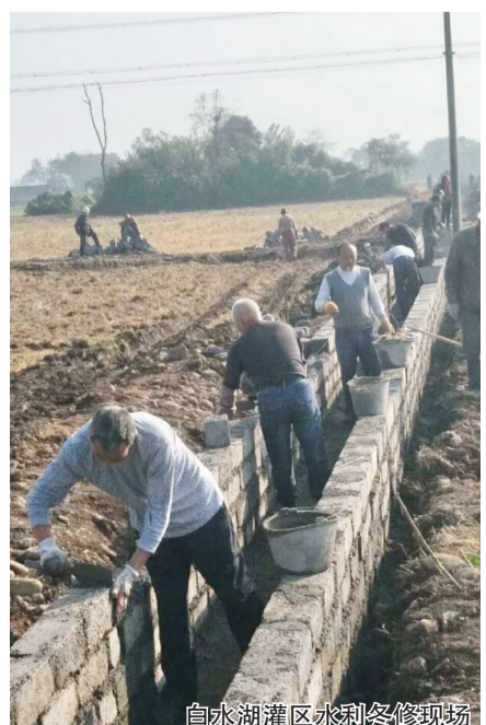
白水湖灌区水利冬修现场
