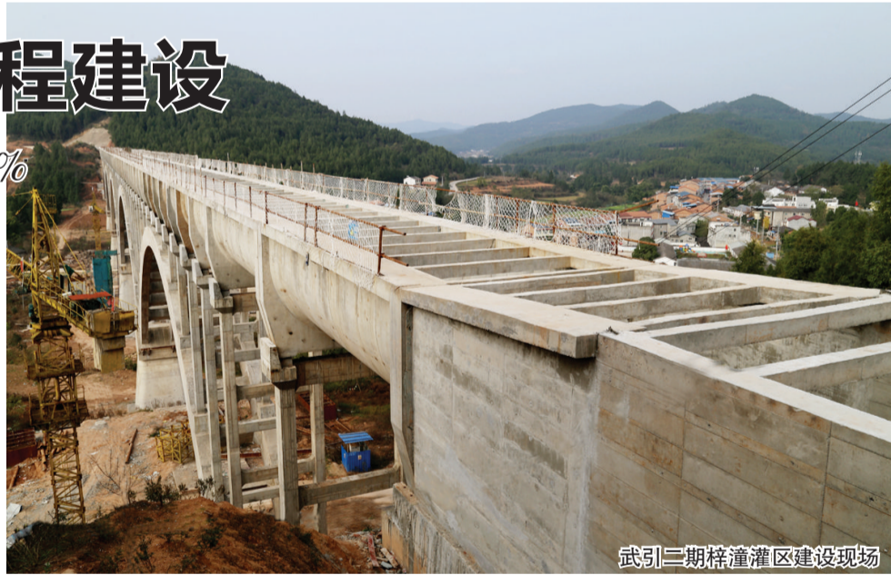
武引二期梓潼灌区建设现场
