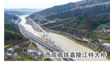
西成高铁嘉陵江特大桥
