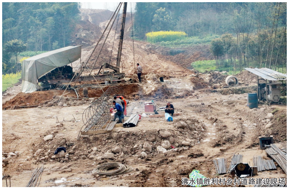
沸水镇胜利村乡村道路建设现场
