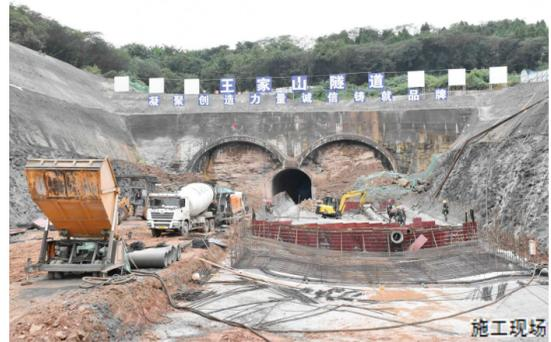
本报讯(记者 田明霞/文 任露/图)记者昨(11)日了解到,长530米的一环路南段工程项目王家山隧道中导洞已于日前贯通,为一环路南段工程的顺利推进打下了坚实的基础。
