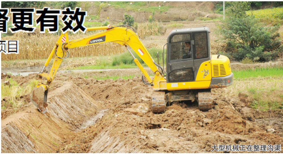
大型机械正在整理沟渠
