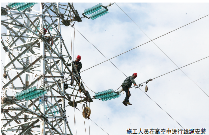
施工人员在高空进行线缆安装
