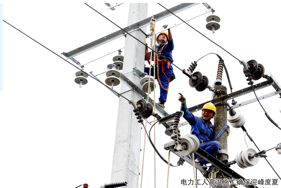
电力工人高温施工确保迎峰度夏
