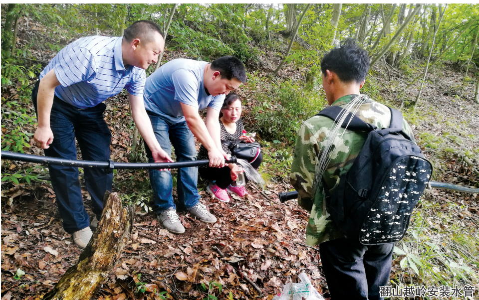
翻山越岭安装水管
