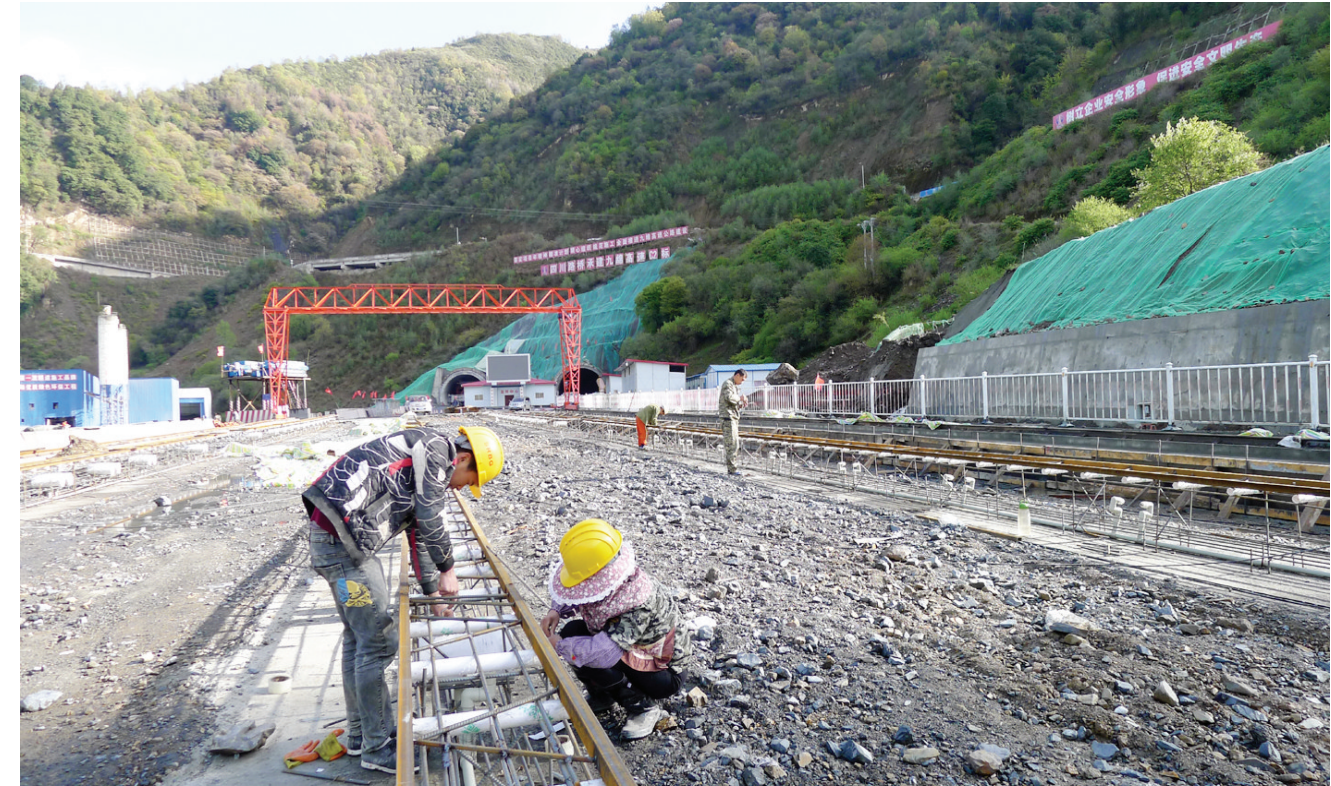
施工人员在白马隧道工地预制梁场上作业
