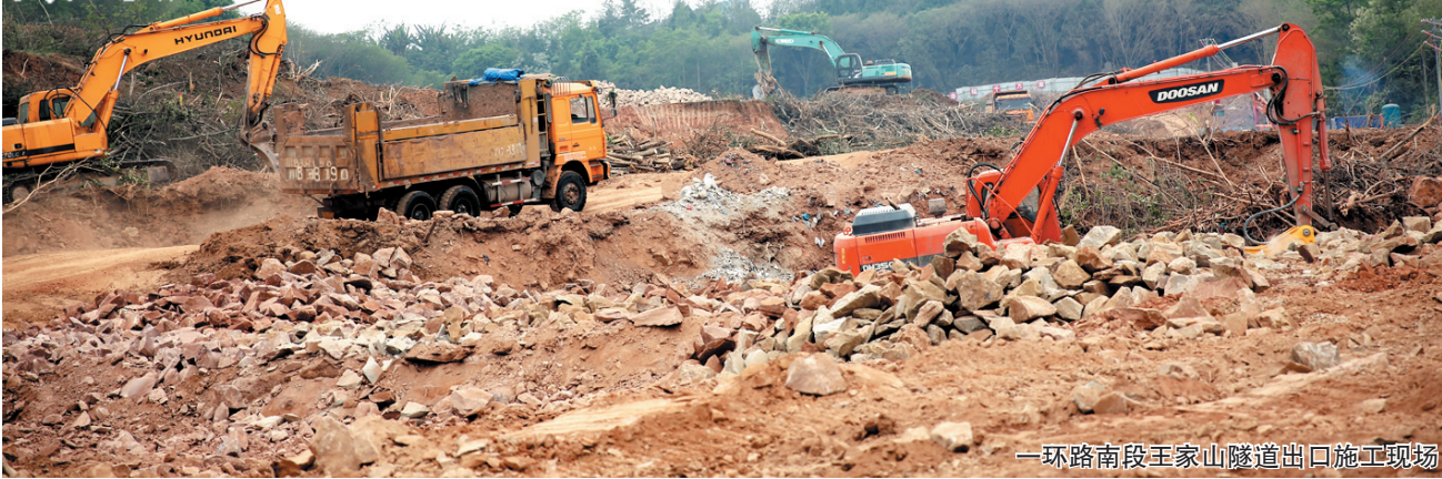
一环路南段王家山隧道出口施工现场
