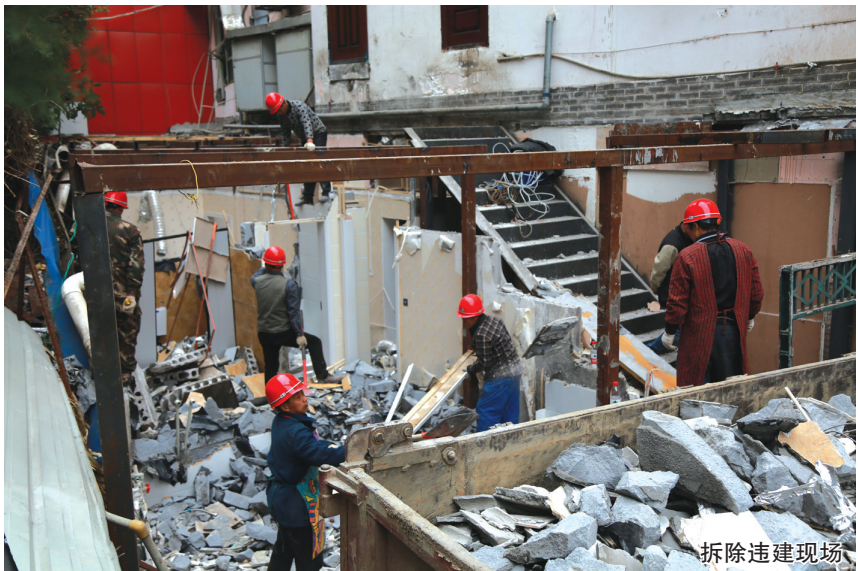
拆除违建现场
