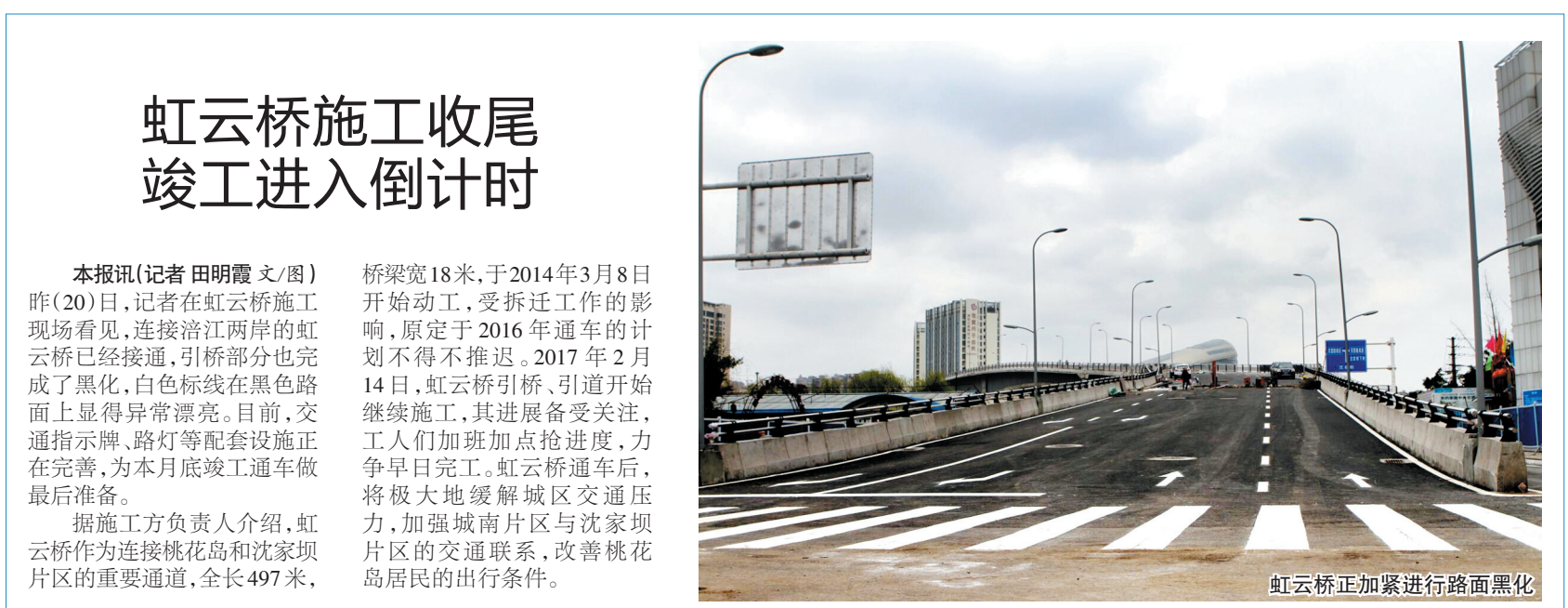
虹云桥正加紧进行路面黑化
