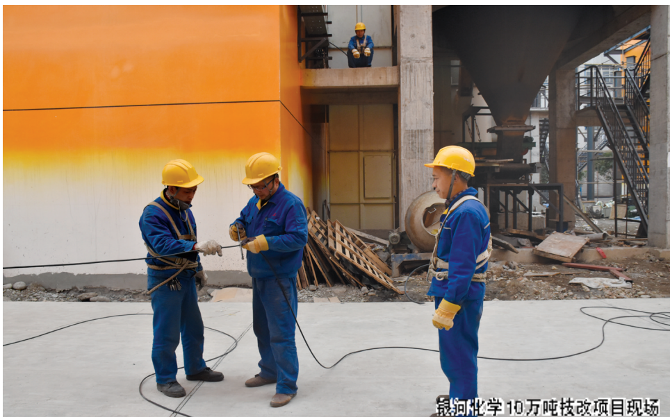
银河化学10万吨技改项目现场
