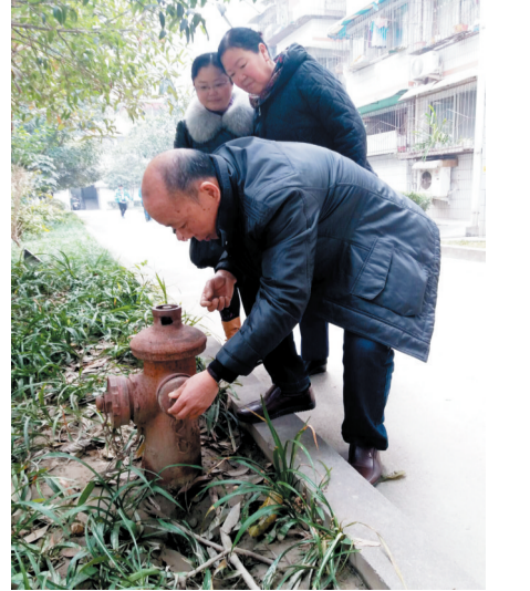
郭德生正在检修消防栓
