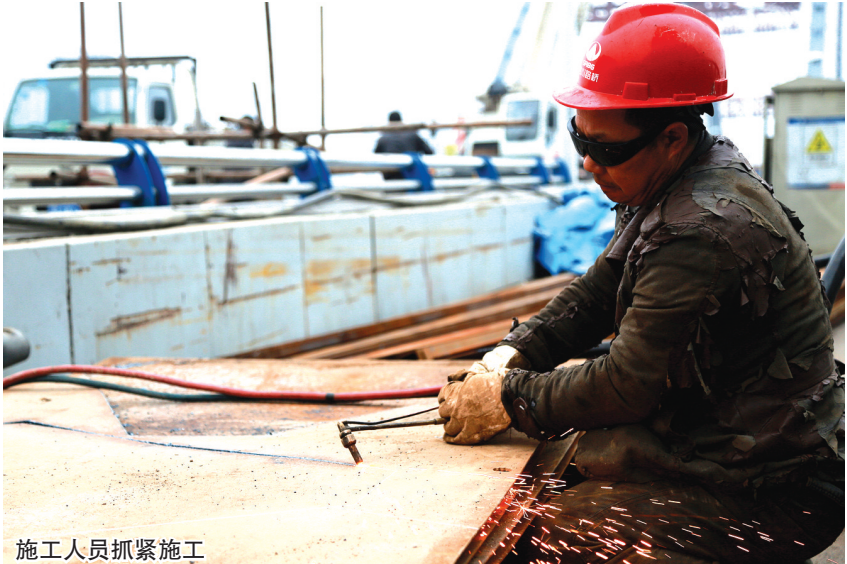
施工人员抓紧施工
