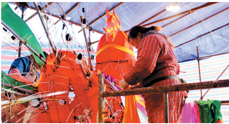
施工人员正抓紧布展
