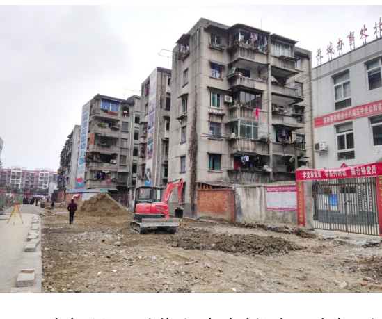
从今年开始，江油将用4年的时间对420个老旧小区进行包括改造硬件、提升风貌、建立机制等内容的治理工作，切实改善居民的居住环境。图为长城办事处北二社区改造现场。(江文 摄)
